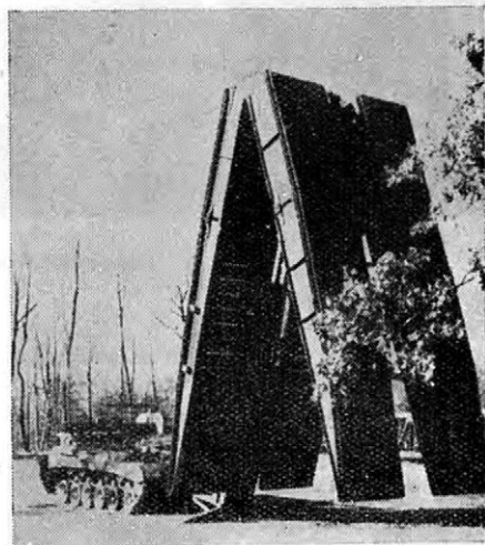
Obr. 12. Mostní tank typu „Scissors“ při kladení nosníku
