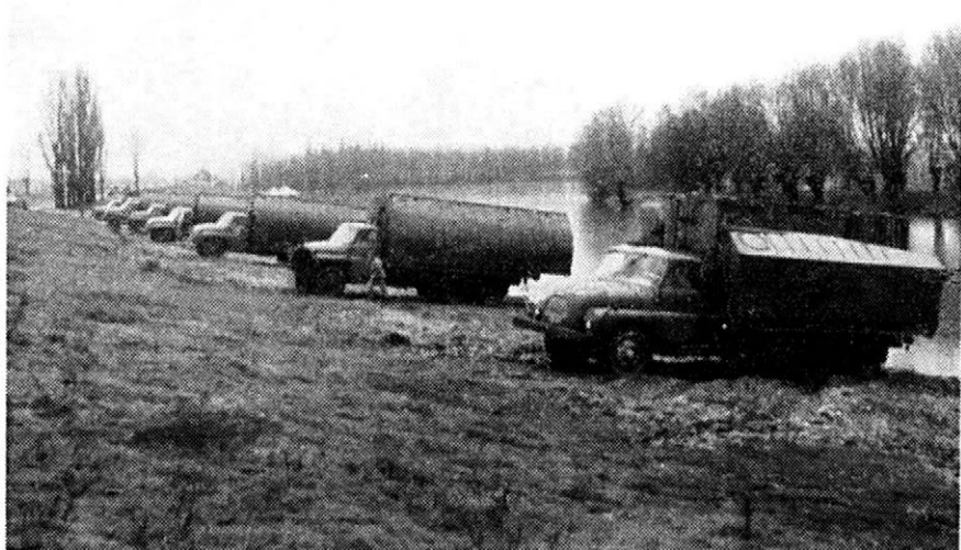
Obr. 4. Kolona pontonových aut T 138 PP16V po příjezdu k řece před spuštěním pontonových dílů na vodu (1. vozidlo zprava s pobřežním dílem, další vozidla s říčními díly)
