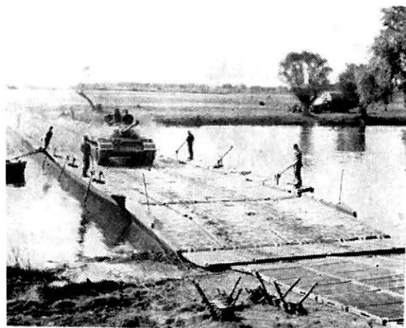
Obr. 1 Most PMS za provozu
