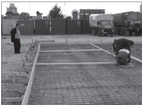
Obr. 2: Uložení karisít a tvorba dilatačních spár
