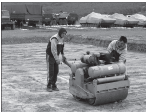
Obr. 1: Zhutnění podloží
