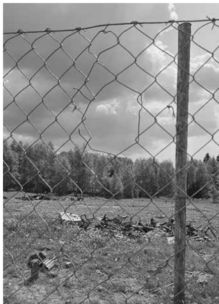
Obrázek č. 8: Poškození pletiva při použití nálože sestavené z bleskovic NPV
