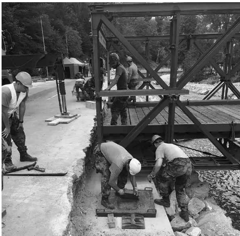
Obrázek č. 11: Uložení mostní konstrukce na úroveň komunikace
