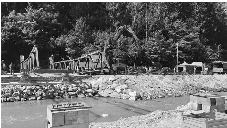
Obrázek č. 10: Výstavba výsuvného krakorce v lokalitě Mežica
