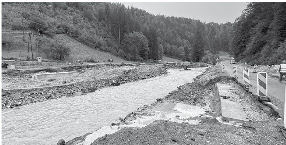
Obrázek č. 4: Vybudované podpěry pro uložení mostu v lokalitě Mežica
