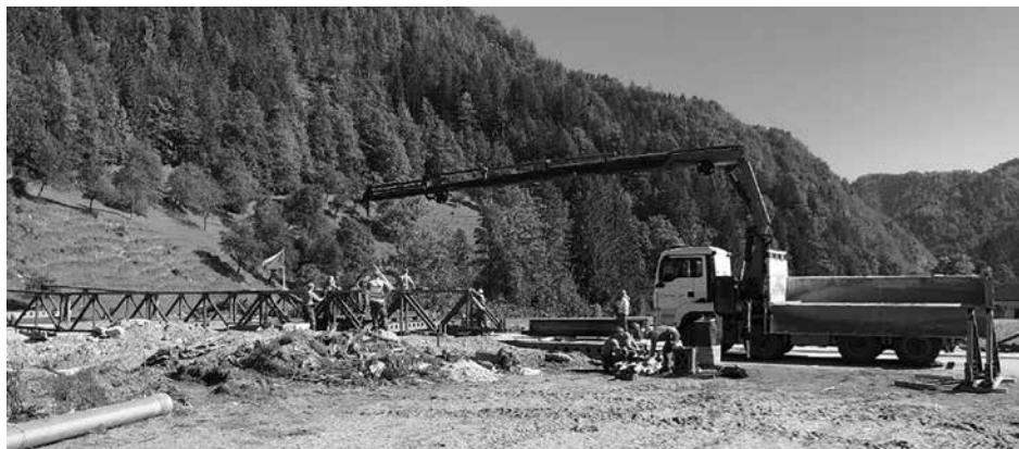
Obrázek č. 8: Využití auta s hydraulickou rukou při stavbě mostu
